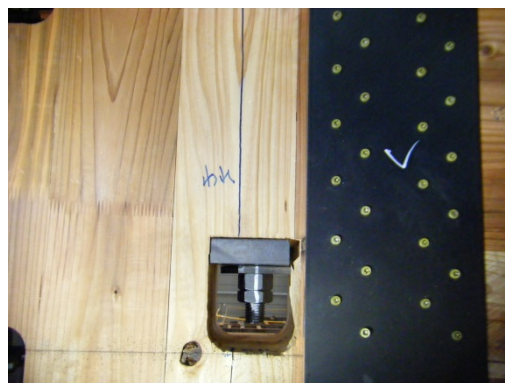
写真 8.7.1-308 引きボルト埋込部の割れ
