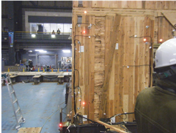
写真 8.7.2-11 壁パネルのラミナ剥離
