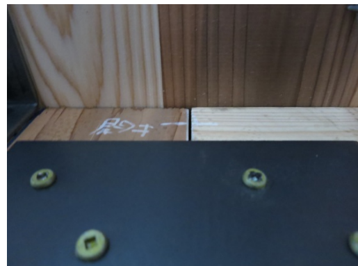
写真 8. 7. 1-228 壁と垂れ壁間の開き
