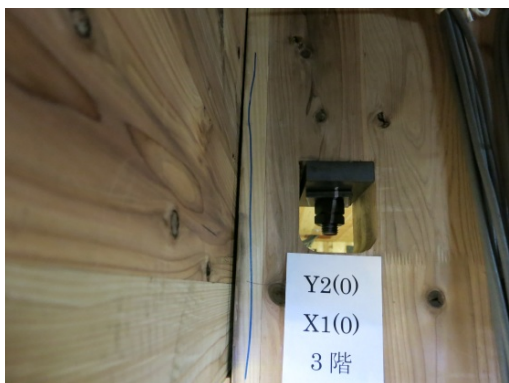
写真 8.7.1-286 壁-直行壁の開き
