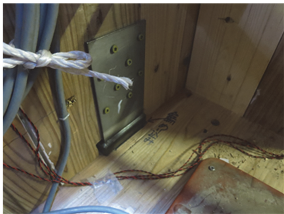
図 8.7.2-43 U形引張金物めり込み
