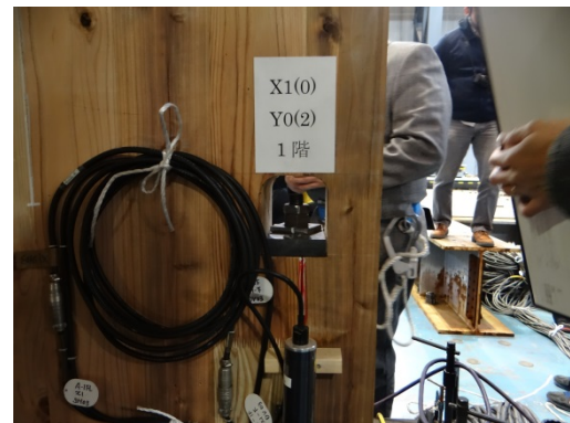
写真 8.7.1-59 壁-基礎引きボルトの緩み
