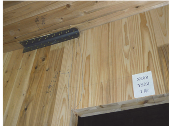
写真 8.7.2-24 床パネルのはがれ
