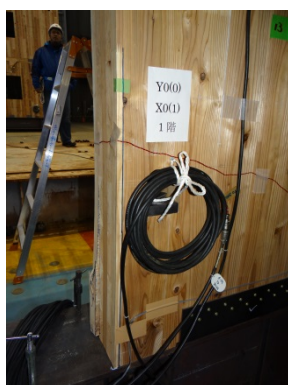
写真 8. 7. 1-121 ラミナの継ぎ目の割れ
