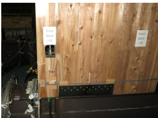
写真 8. 7. 1-63 壁パネルと基礎接触面からの 割れ
