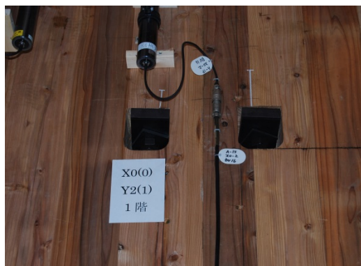
写真 8. 7. 1-47 表層ラミナの割れ
