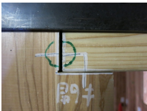
写真 8. 7. 1-239 壁と垂れ壁間の開き
