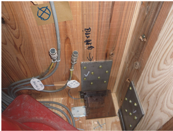
写真 8.7.2-50 U形引張金物ずれ
