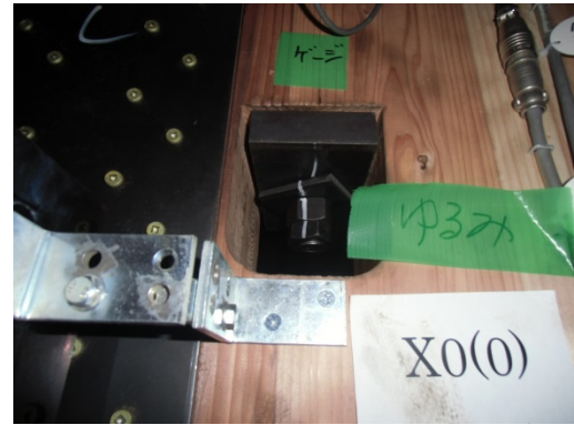
写真 8. 7. 1-166 壁-壁引きボルトの緩み
