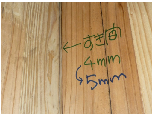
写真 8. 7. 1-138 壁パネル間の開き
