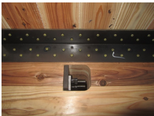
写真 8. 7. 1-210 L 形金物ビスの浮き
