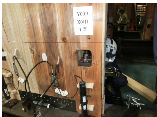
写真 8.7.1-37 壁パネル側面割れ
