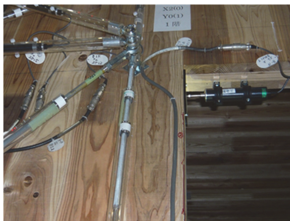
写真 8.7.2-7 壁パネルの割れ
