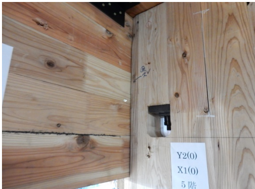
写真 8.7.1-327 壁パネルのずれ
