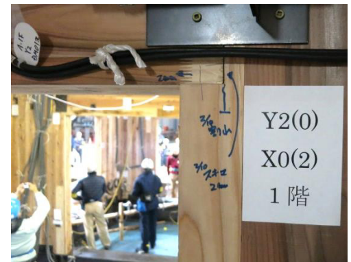
写真 8. 7. 1-139 垂れ壁-壁の開きと割れ
