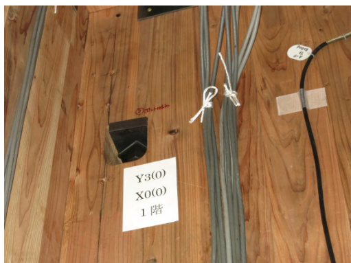
写真 8. 7. 1-61 壁-屋根引きボルトの緩み
