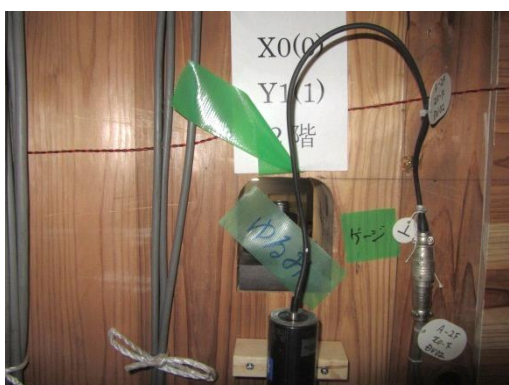
写真 8.7.1-180 壁と腰壁とり合い部の割れ
