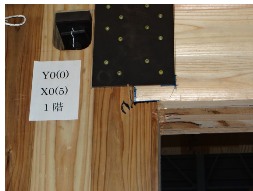
写真 8. 7. 1-124 垂れ壁-壁取り付け部の潰れ
