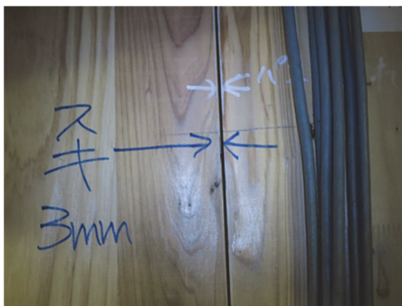
写真 8.7.2-41 壁パネル間の開き
