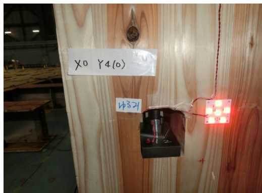
写真 8.7.1-19 基礎-壁引きボルトの緩み
