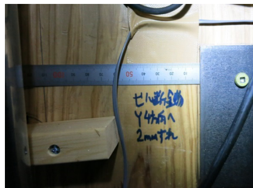
写真 8. 7. 1-101 U形せん断金物のずれ
