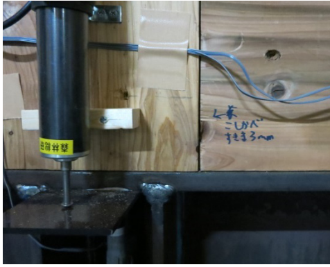
写真 8. 7. 1-112 腰壁-壁間の隙間
