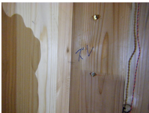
写真 8. 7. 1-313 壁のずれ
