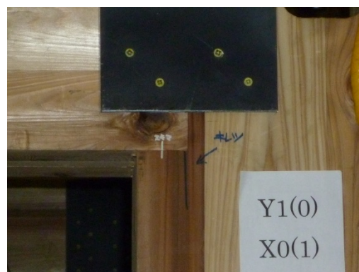
写真 8. 7. 1-126 垂れ壁-壁取り付け部の潰れ
