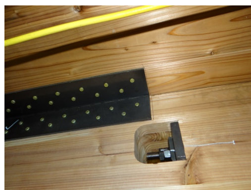
写真 8.7.1-91 L 形せん断金物のずれ
