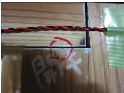
写真 8. 7. 1-235 垂れ壁と壁間の開き
