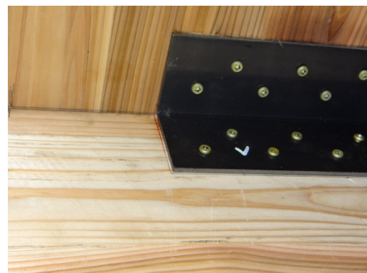
写真 8. 7. 1-134 L 形せん断金物のずれ
