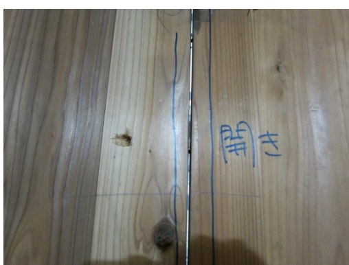
写真 8. 7. 1-261 壁パネル間の開き X1 通り
