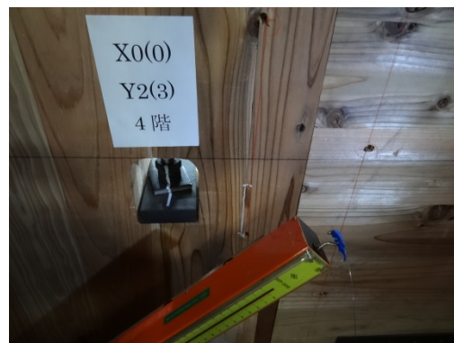
写真 8. 7. 1-288 ラミナ継ぎ目の開き
