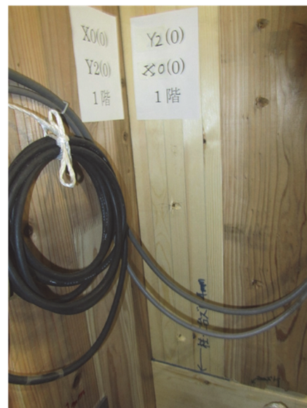
写真 8.7.2-35 柱・土台のずれ
