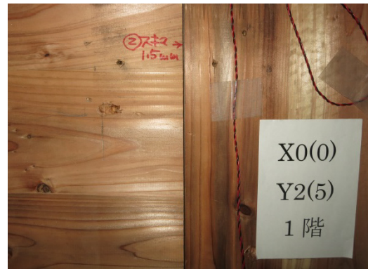
写真 8.7.1-57 壁パネル間の開き
