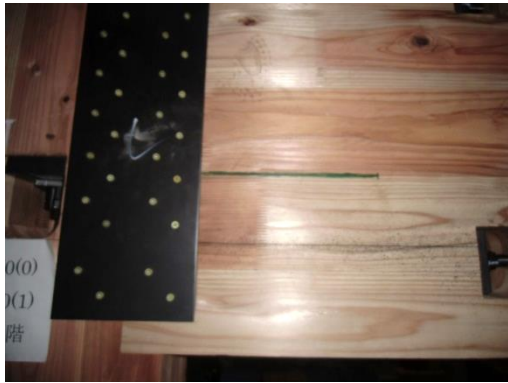
写真 8. 7. 1-165 ラミナ継目の割れ
