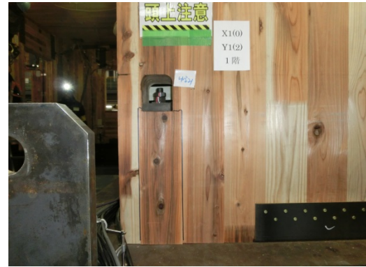
写真 8.7.1-30 壁-基礎引きボルト緩みと割れ
