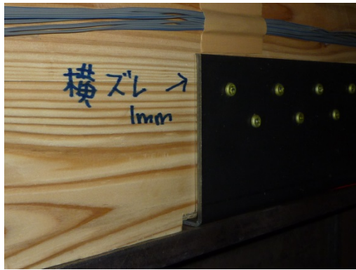
写真 8. 7. 1-96 U形せん断金物のずれ
