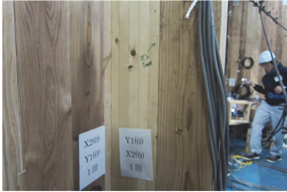
写真 8.7.2-30 壁パネルのずれ
