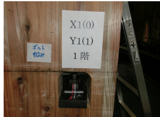
写真 8.7.1-28 壁-基礎引きボルト
