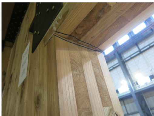
写真 8.7.1-279 垂れ壁と壁の開き
