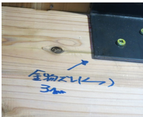
写真 8. 7. 1-152 L 形せん断金物のずれ
