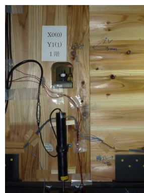
写真 8.7.1-95 壁-基礎引きボルトの緩み
