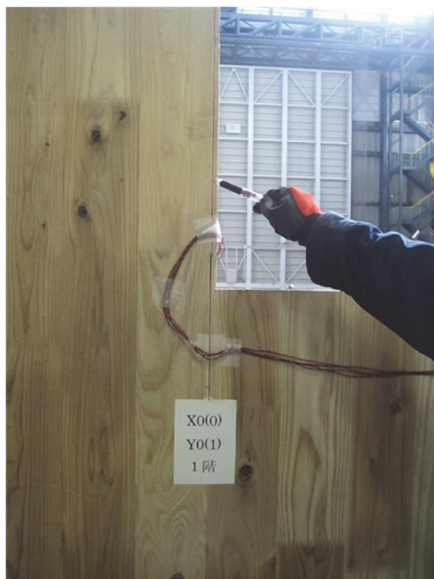
写真 8.7.2-18 壁パネルの割れ
