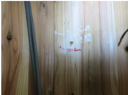
写真 8. 7. 1-53 壁間の隙間
