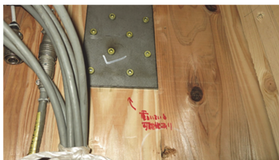
図 8.7.2-42 U形引張金物ずれ
