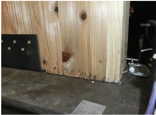
写真 8.7.1-29 壁パネル下部の圧縮潰れ
