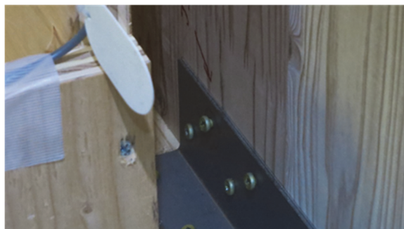
写真 8.7.2-40 L型せん断金物ねじ抜け
