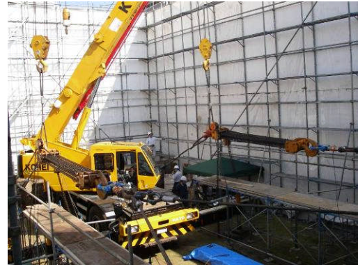
写真 2.2.2-5 500kN チェーン ブロックの設置状況
