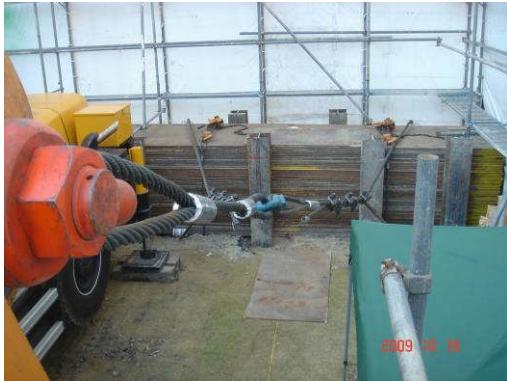
写真 2.2.2-4 敷鋼板 2000kN 分の 設置状況
