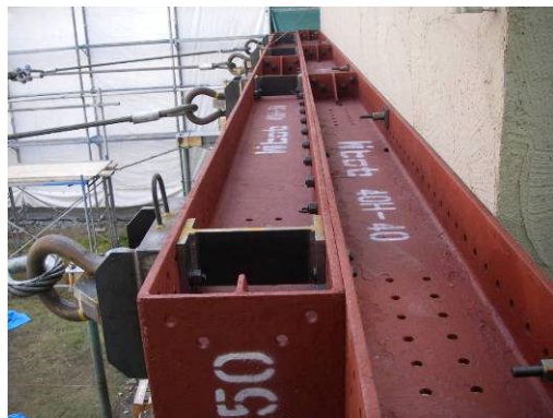
写真 2.2.2-6 H 形鋼および スチフナーの設置状況
