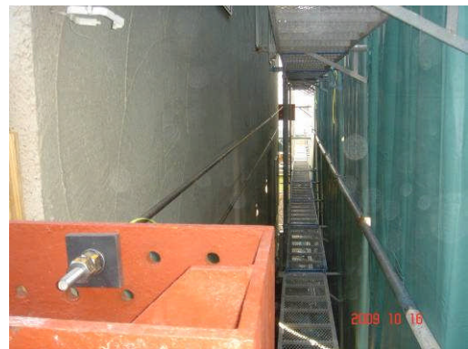
写真 2.2.2-7 PC 鋼棒と H 形鋼の 緊結状況
